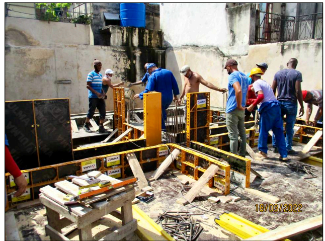
Baustelle in der Altstadt von Havanna. (Bild zvg)
