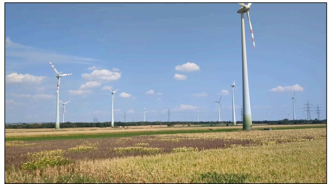
Heute üblich gewordene Rotoren mit etwa 80 m Länge haben eine Gesamtoberfläche von 250 bis 350 qm. Eine Windanlage mit drei solcher Rotoren hat mithin eine Gesamtoberfläche von bis etwa 1000 qm. (Bild zvg)
